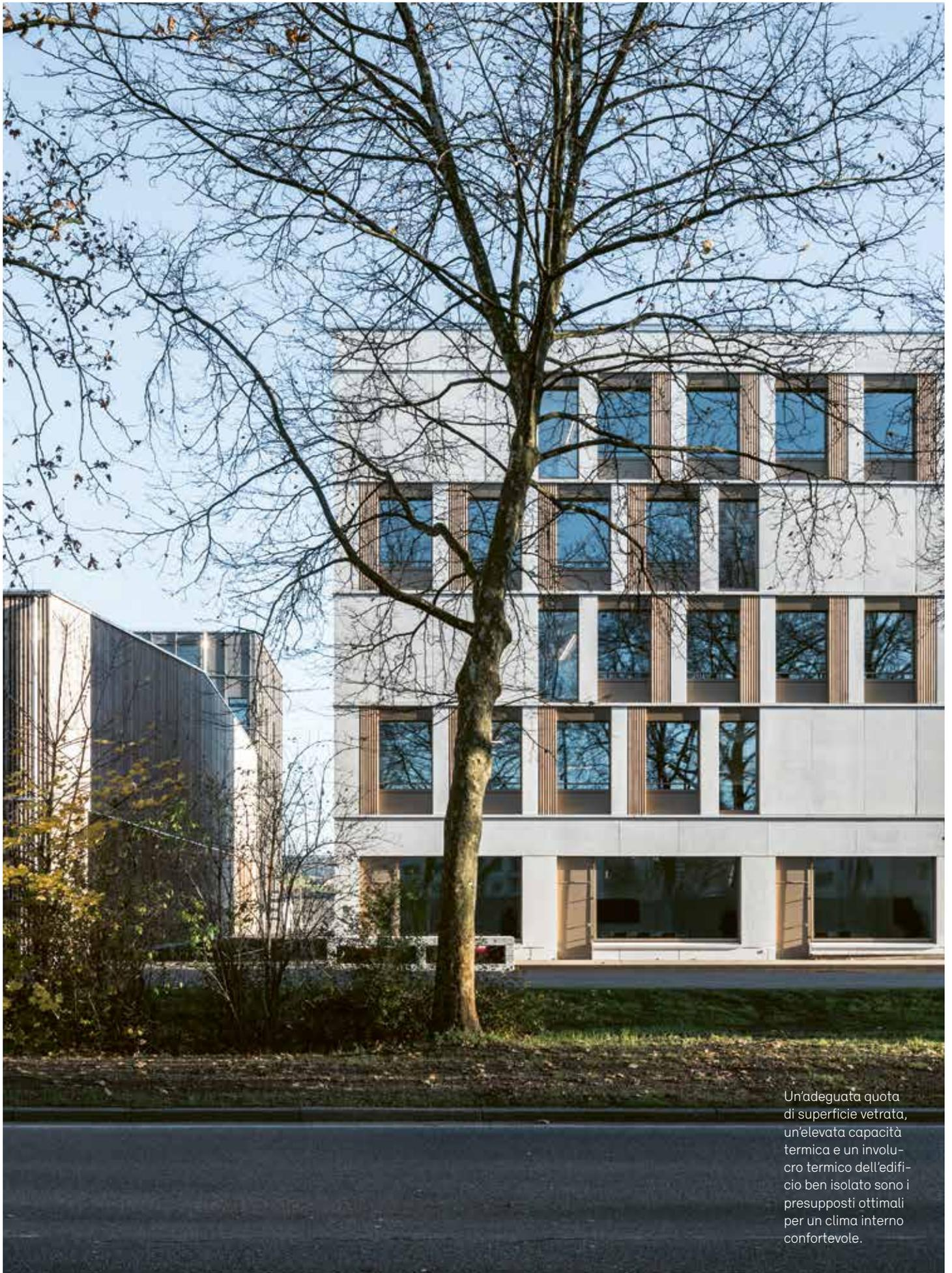
Un'adeguata quota di superficie vetrata, un'elevata capacità termica e un involucro termico dell'edificio ben isolato sono i presupposti ottimali per un clima interno confortevole.
