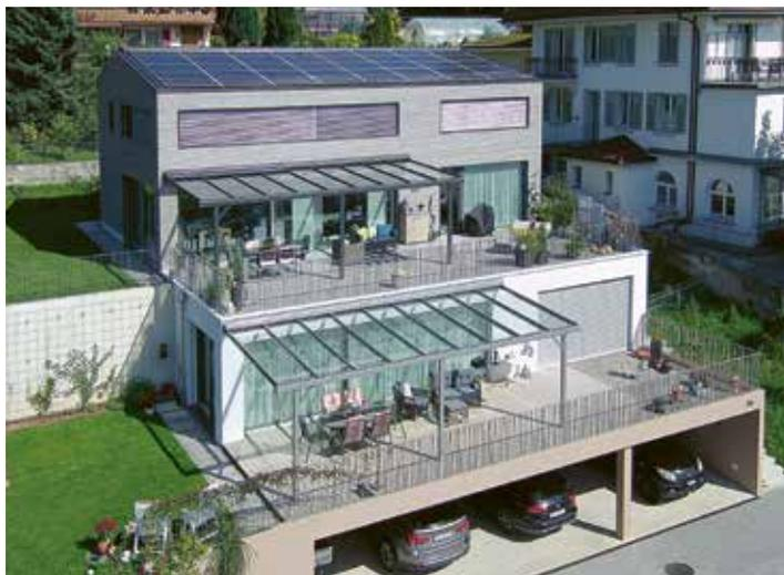
**Grazie alla protezione solare, controllata da un sistema di gestione dell'energia, l'edificio ha una temperatura interna piacevole anche in estate.**
