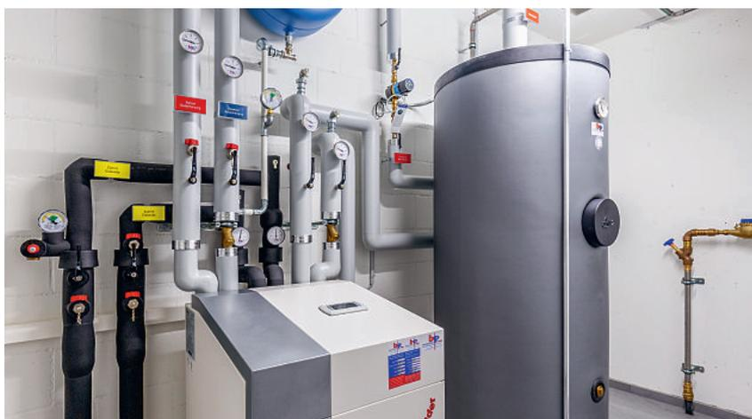
Figure à gauche : l'alimentation en chaleur de la maison bifamiliale Minergie se fait par une pompe à chaleur eau glycolée/eau à modulation intégrale avec un refroidissement passif via la sonde géothermique (« free cooling »). La pompe à chaleur installée dans la cave associée à l'installation photovoltaïque sur le toit assure de l'eau chaude et des températures ambiantes agréables.
