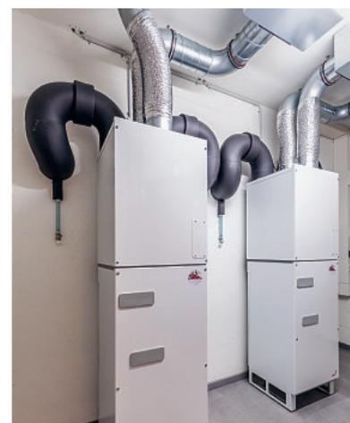
Figure à droite : Dans la maison bifamiliale en bois climat à Schriedrud, un appareil de ventilation de Zehnder a été installé dans la cave pour chaque logement. Bien que très performant, le Zehnder ComfoAir SL 330 est extrêmement compact et requiert donc un faible encombrement n'empiétant pas sur l'espace de rangement.
