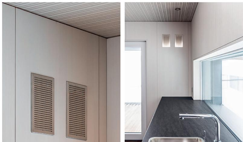
Échange d'air confortable : dans les cuisines, l'air ambiant et l'excédent d'humidité sont repris et rejetés vers l'extérieur. Cela prévient efficacement la formation de moisissures et de dégâts. Seules les élégantes grilles de sortie d'air en acier inoxydable brossé sont visibles.
