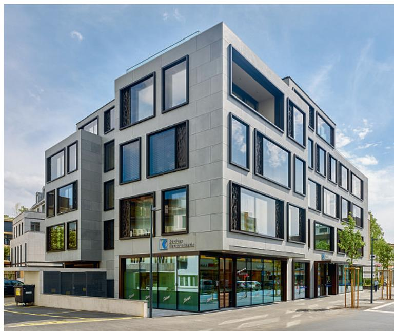
La succursale de la Banque Cantonale de Zurich à Uster a été reconstruite selon le label Minergie-ECO et génère de la chaleur à l'aide d'une pompe à chaleur géothermique. Une partie de l'électricité est générée par un système photovoltaïque et une partie de l'eau chaude par des capteurs solaires.
