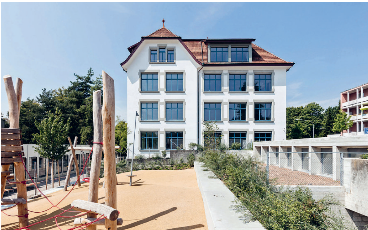
Aussenansicht des erneuerten Schulhauses Bläsi in Zürich-Höngg.
