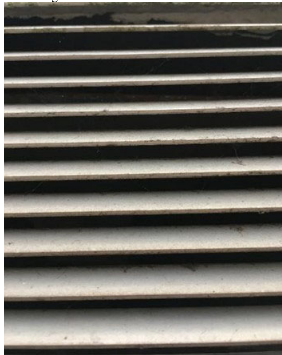
Abbildung 83: WNG ID 610: AUL-Durchlass
