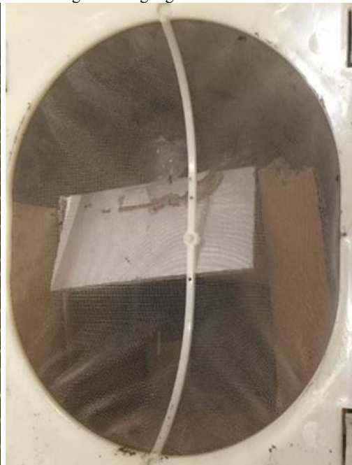
Abbildung 96: Fliegengitter beim Gerät
