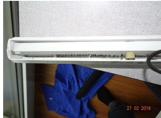
Abbildung 148: WNG ID 710: Ablagerung an ZUL-El.
