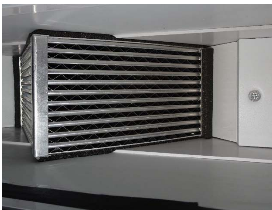
Abbildung 131: WNG ID 610: Wärmetauscher
