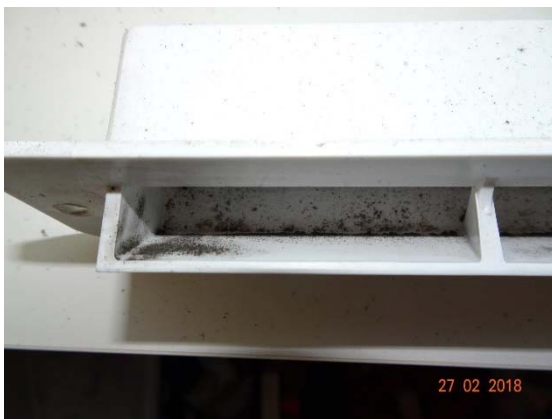
Abbildung 156: WNG ID 720: Ablagerung an ZUL-El.
