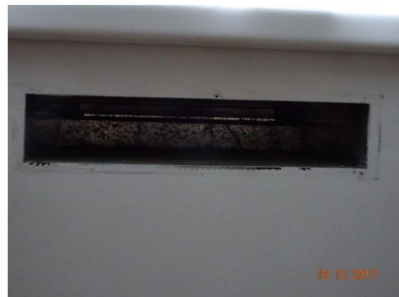
Abbildung 97: WNG ID 420: Durchbruch AUL-Eintritt
