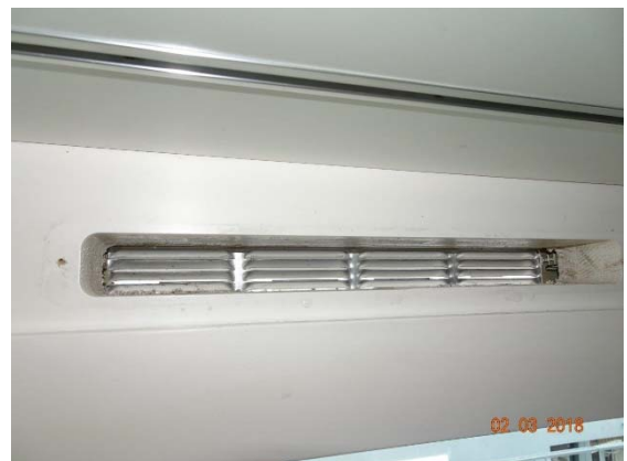
Abbildung 168: WNG ID 730: Durchbruch AUL v.I.
