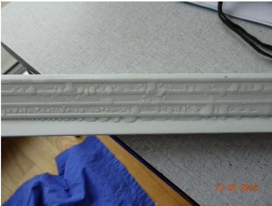
Abbildung 145: WNG ID 710: Kondensat an ZUL-El.
