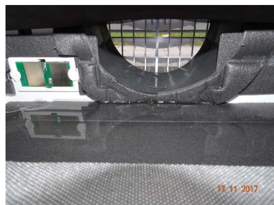
Abbildung 46: WNG ID 210: Kondensat in Gerät
