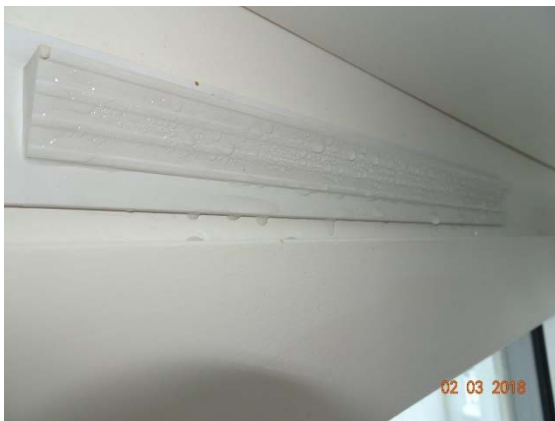
Abbildung 165: WNG ID 730: Kondensat an ZUL-EI.
