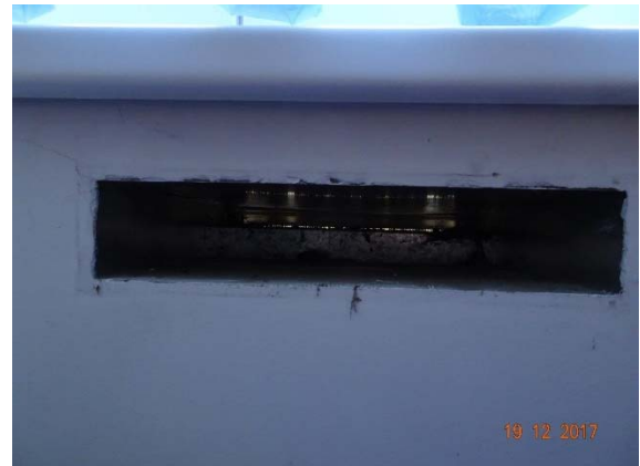
Abbildung 86: WNG ID 410: Durchbruch AUL-Eintritt
