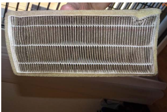
Abbildung 125: WNG ID 610: Zuluftfilter
