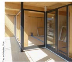
Abbildung 120: Gebäudetyp 11 Leichtbau – Stützträgersystem Holz, Aussenwände aus Brettsperrholzplatten.
