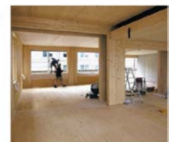
Abbildung 119: Gebäudetyp 10 Leichtbau – Stützträgersystem Holz, Aussenwände in Holzrahmenbau.
