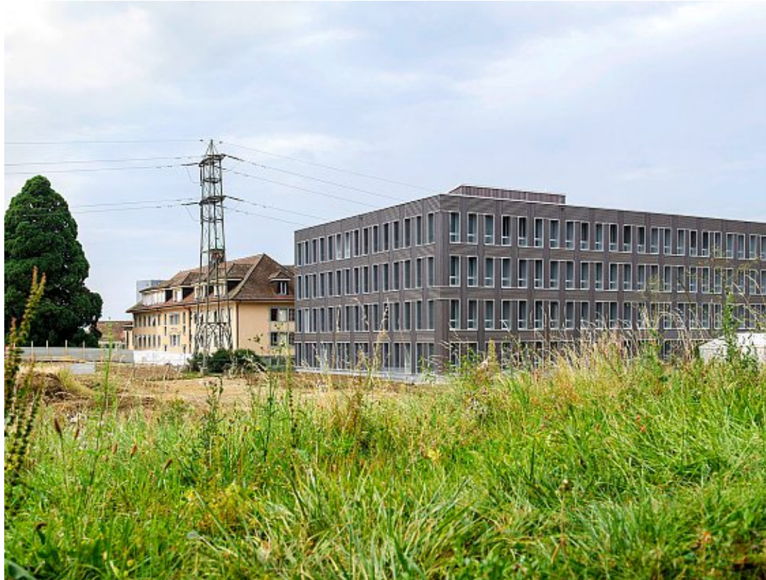
La Maison de l'environnement, à Lausanne, a été certifiée Minergie. VANESSA CARDOSO
