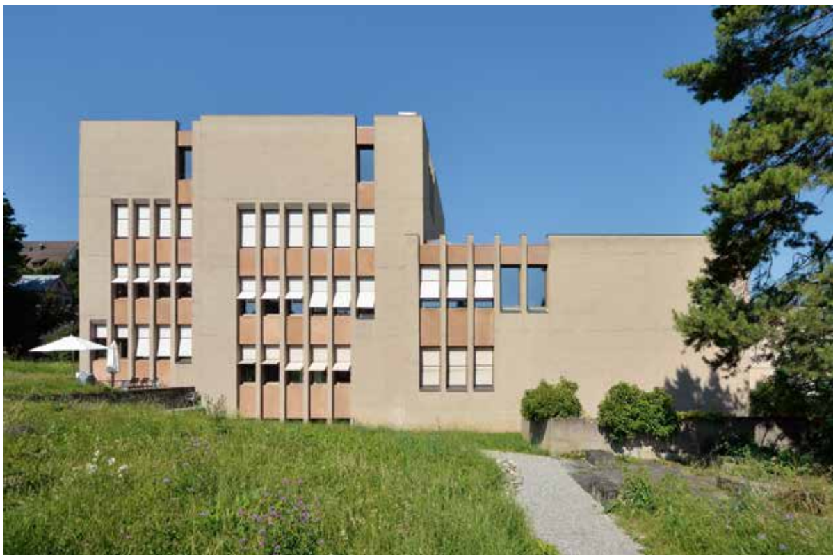
Le finestre di facciata assicurano la connessione visiva con il mondo esterno.
