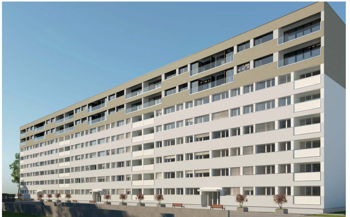
Surélévation d'immeuble, rue de la Prulay, à Meyrin.
